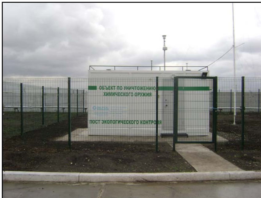
Фото 4 – Автоматический стационарный пост контроля воздушной среды
