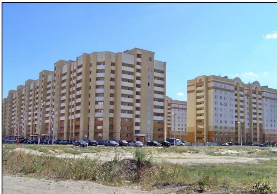
Фото 9 - Жилые дома в мкр-не Сосновка
